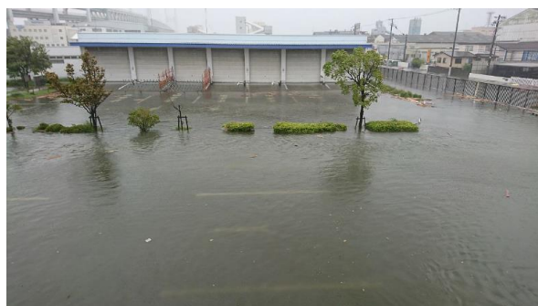
台風21号の高潮で魚崎庁舎敷地が冠水した写真
